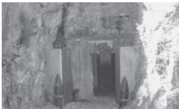
Ingång stabs- och förläggningstunnel
